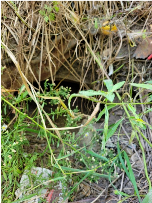
#3- Centerline Culvert 1, inlet
